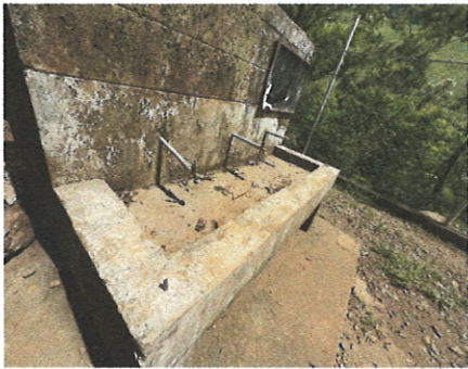
Foto 4: MEJORAMIENTO DE SERVICIO SANITARIO Y ACCESORIOS Y SERVICIO DE LAVAMANOS Y ACCESORIOS
