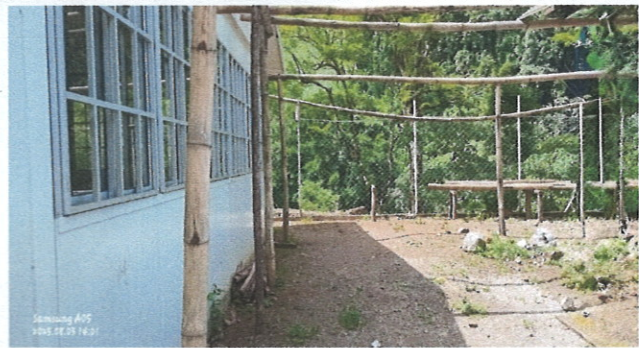
Foto1: MEJORAMIENTO DE PARED Y SUMINISTRO E INSTALACION DE CIMIENTO CORRIDO
