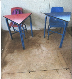
Foto 5: MEJORAMIENTO DE PISO DE CONCRETO
