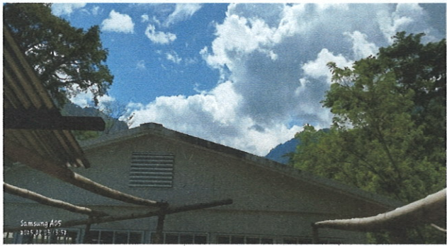
Foto 2: MEJORAMIENTO DE ESTRUCTURA DE TECHO DE LAMINA
