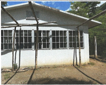
Foto 6: MEJORAMIENTO DE CORREDOR MODULO
