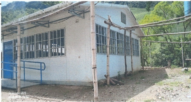
Foto 3: SUMINISTRO E INSTALACION DE PUERTAS Y VENTANAS
